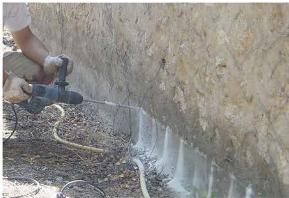
Préparation d'une barrière d'injection
